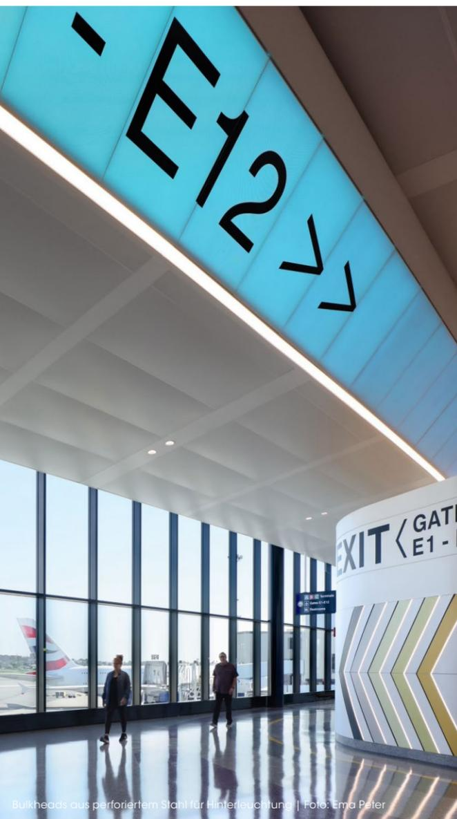
Bulkheads aus perforiertem Stahl für Hinterleuchtung | Foto: Ema Peter
