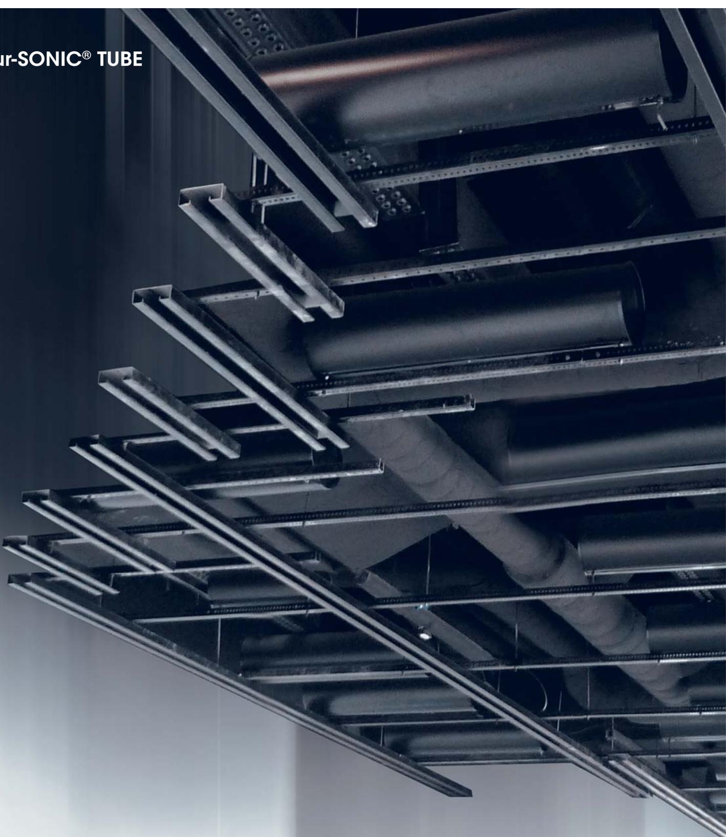
**D** dur-SONIC® TUBE ist ein Breitbandabsorber, der zur Verbesserung der Akustik in Räumen mit offenen Deckensystemen eingesetzt wird. Idealerweise wird er verborgen im Deckenhohlraum über der offenen, abgehängten Decke angebracht. Durch seine kompakte Form und seiner wahlweisen schwarzen Oberfläche entfaltet der dur-SONIC® TUBE dabei nahezu unsichtbar seine Wirkung.
