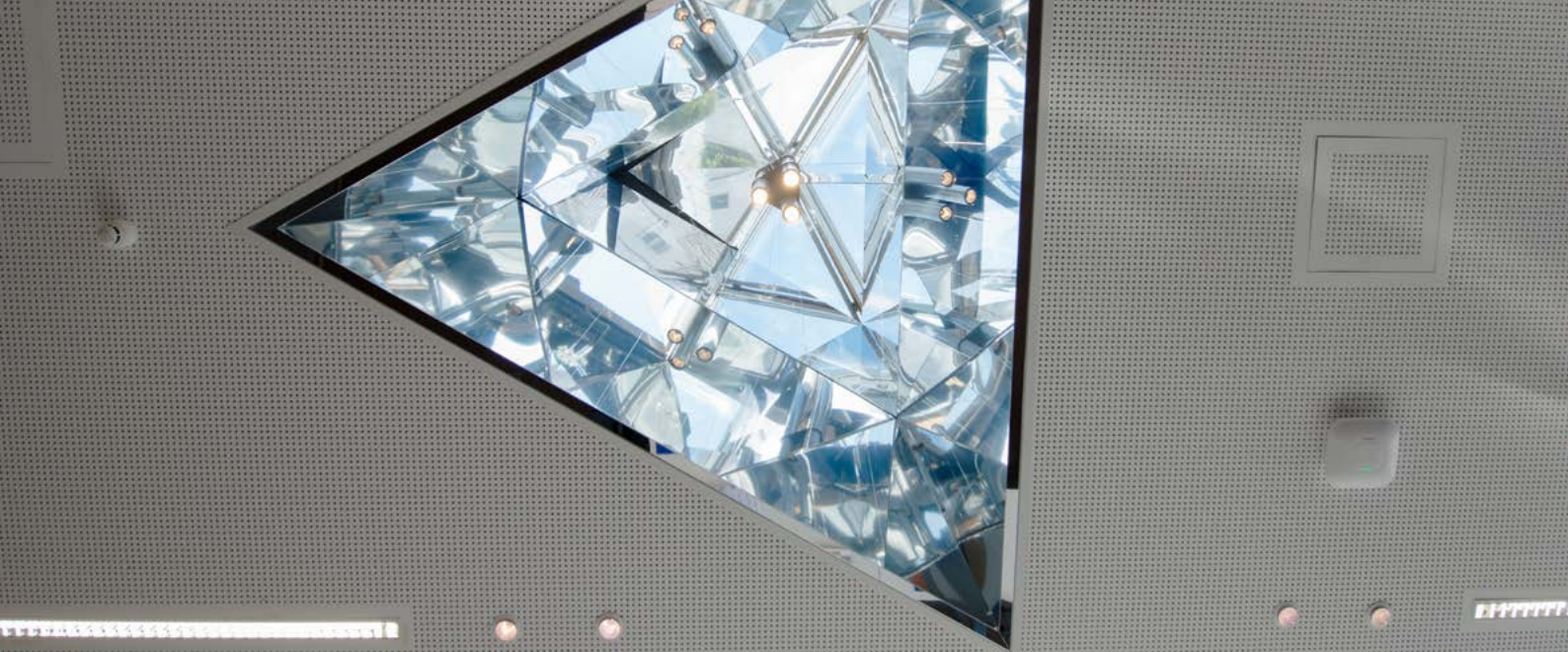
Bildungsstätte der Berufsgenossenschaft, Augsburg | Tageslichtlenkung mit integrierten PUNTEO-J60 Downlights | Foto: Julia Schambeck
